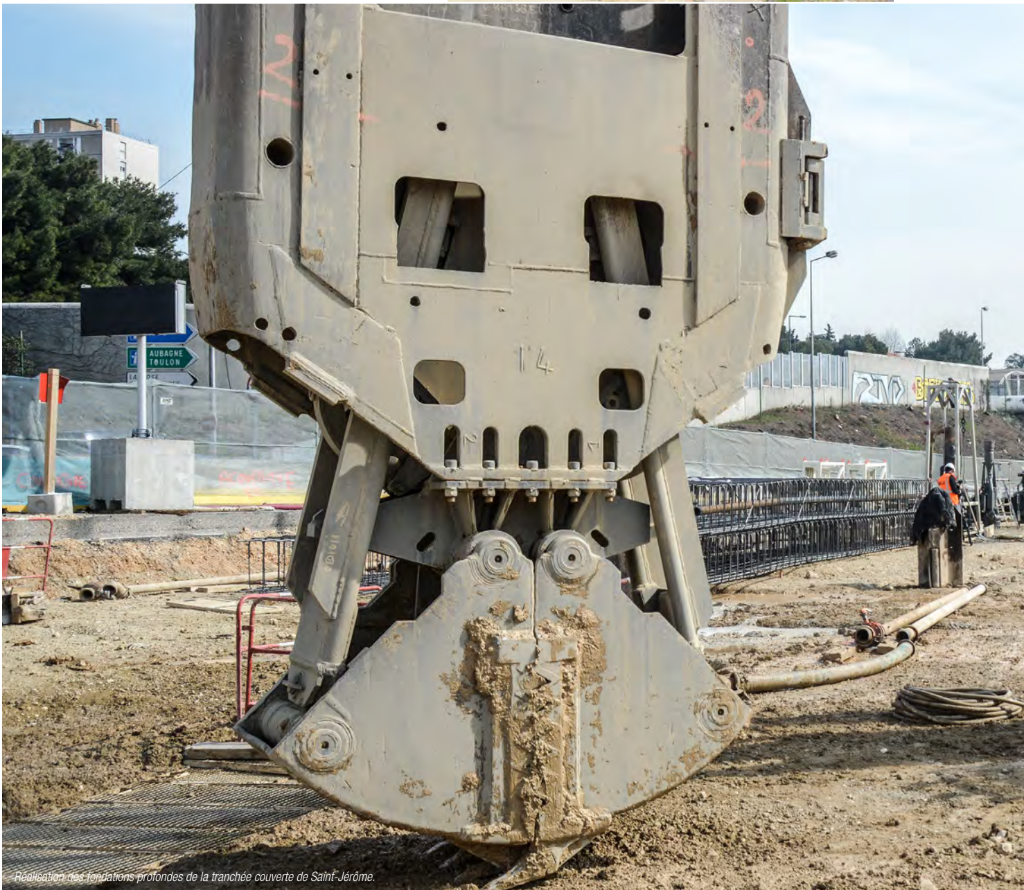
Travaux rue Queillau
