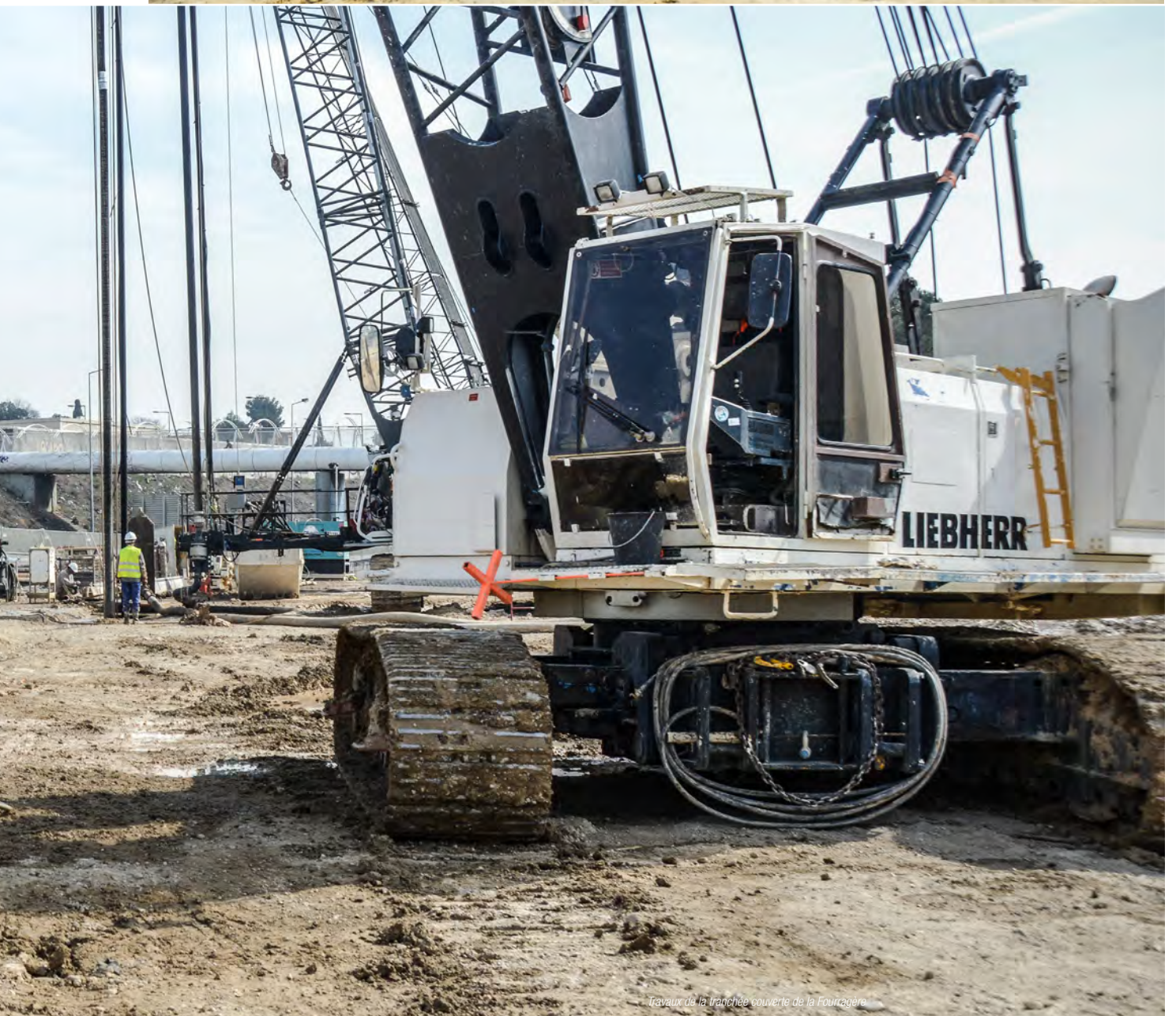
Travaux de prolongement de la tranchée couverte de La Fourragère.
