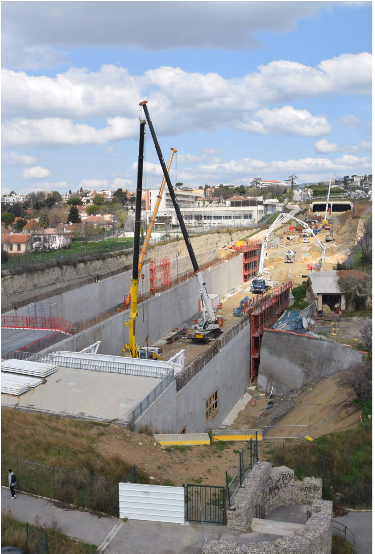
Prolongement de la tranchée couverte de la Fourragère, début 2015, le secteur le plus actif en terme de travaux sur la L2 Est
